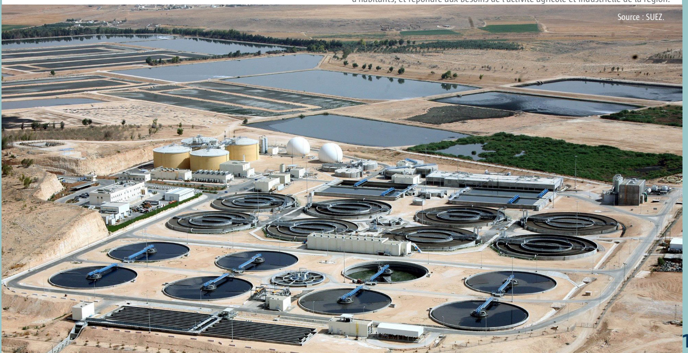
Située en plein désert, à quelques kilomètres de la capitale Amman, la nouvelle station d'As Samra doit assurer le traitement des eaux usées de 2,2 millions d'habitants, et répondre aux besoins de l'activité agricole et industrielle de la région.
